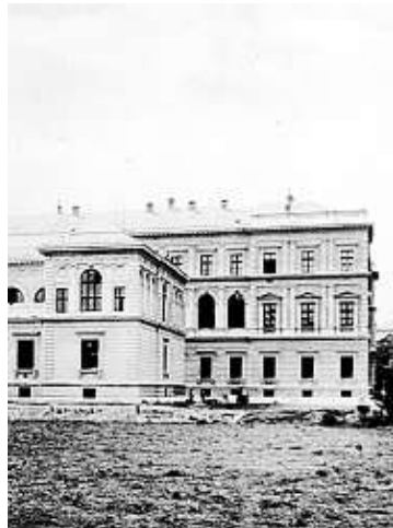
UB einst nach der Errichtung KFU
